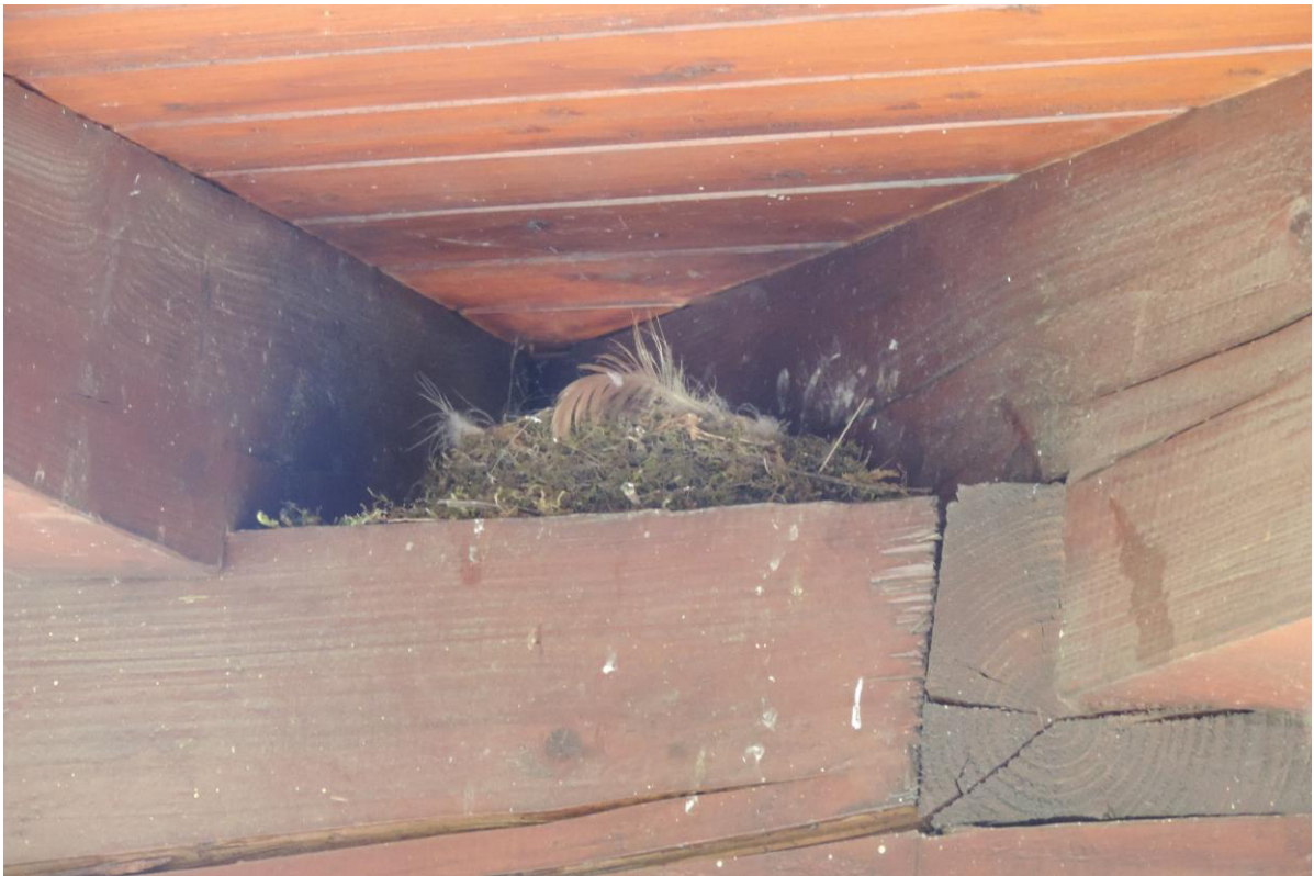
Abbildung 7: offene Balkenkonstruktion des nördlichen Gebäudeteils mit Hausrotschwanznest
